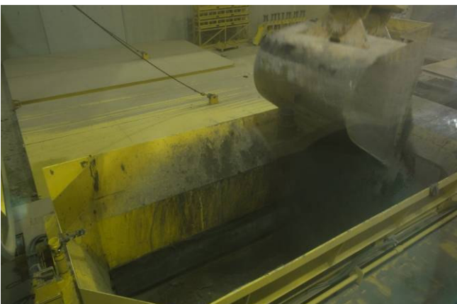
Abb. 11: TC-Befüllung vom Schwarzbereich aus
