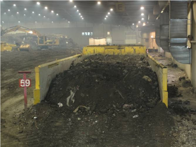
Abb. 9: Mobile Lagerbox mit Haufwerk
