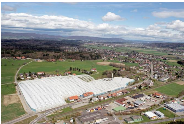
Abb. 1: Einhausung der Sondermülldeponie Kölliken
